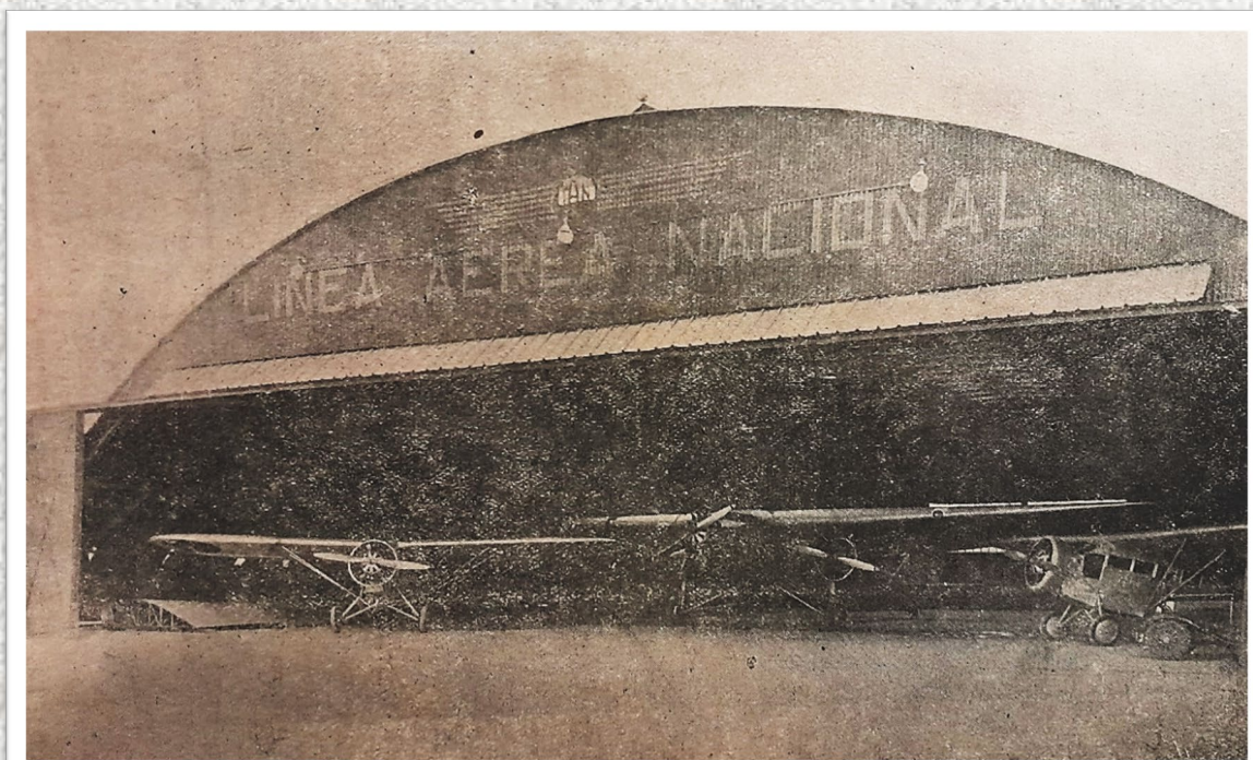
El Hangar metálico "Junkers" de la Posta Santiago. Al lado del trimotor Ford (al centro), se pueden ver los aviones 14 y 15, construidos en los Talleres de la Línea Aérea Nacional
