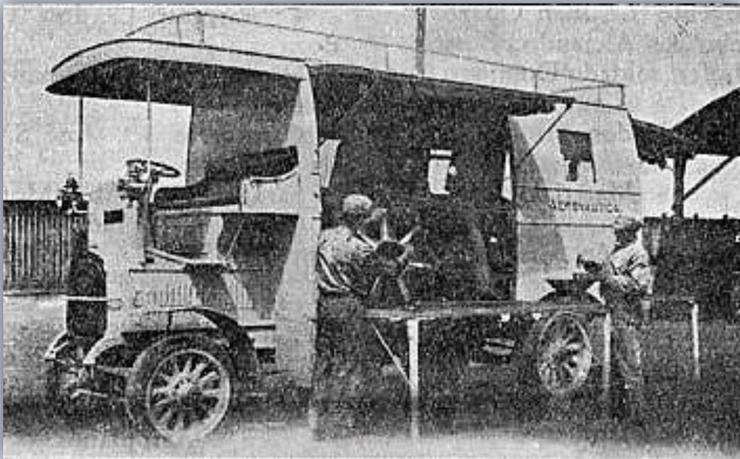
*Auto-taller Delaye para el transporte de repuestos y herramientas y reparaciones de línea.*
