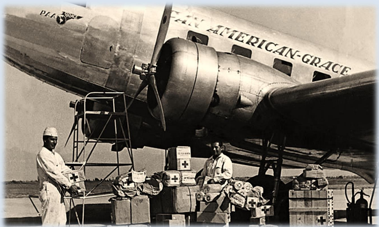
Los Cerrillos fue un centro de acopio de la ayuda internacional aerotransportada. (Documentación El Mercurio)
