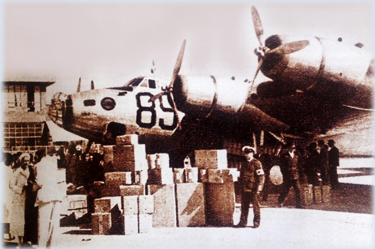
Descargando el YB-15 en la losa de Los Cerrillos
