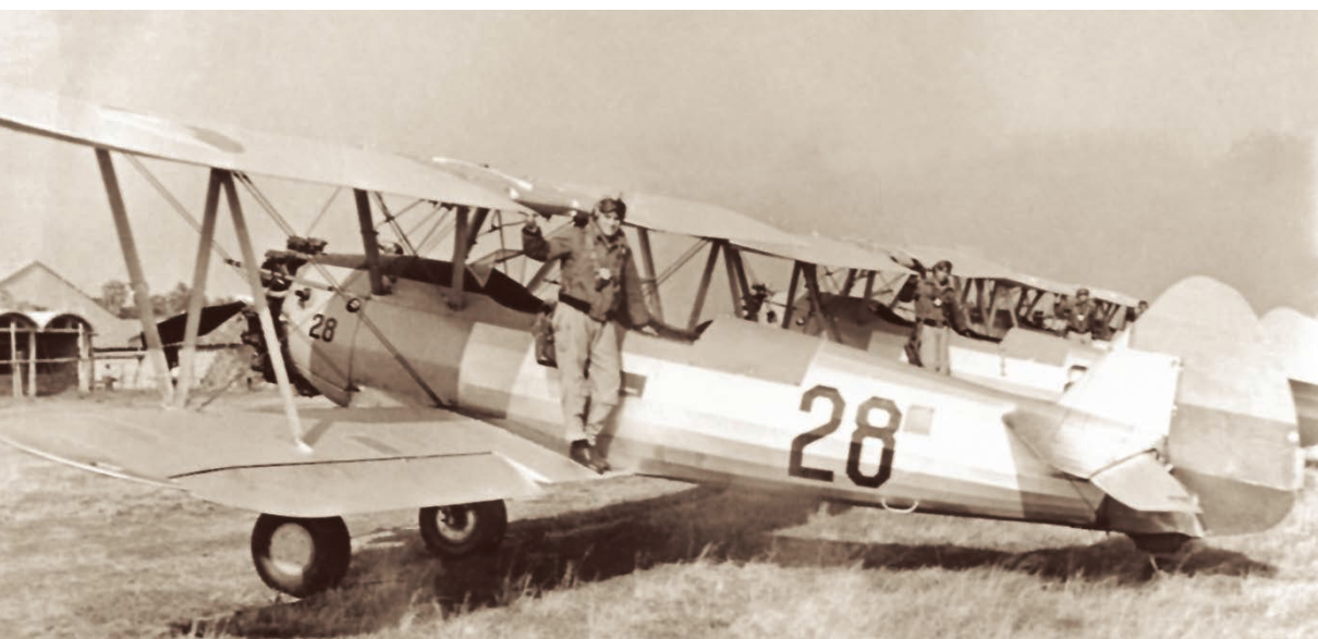
Figura 56. Avión Curtiss Trainer NK-1, de fabricación estadounidense, adquirido en 1933 y empleado para el entrenamiento de pilotos alumnos en la nueva Escuela Militar de Aviación (Cali, Valle del Cauca). Fuente: Gustavo Arias de Greiff, archivo fotográfico personal (obra de dominio público)
