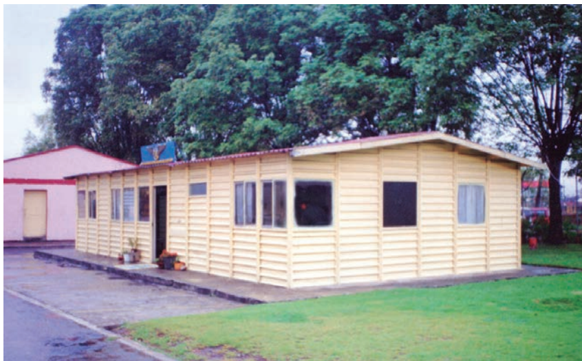
Figura 88. Primeras instalaciones, conocidas como "Casa de Lata", asignadas a la Aviación del Ejército durante su época como DAE, a finales de 1993.
