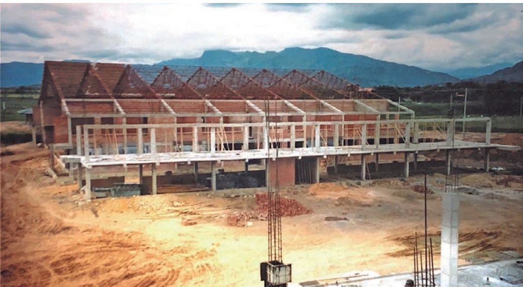
Figura 104. Avance de obra del hangar de UH-60 (junio de 1997).
