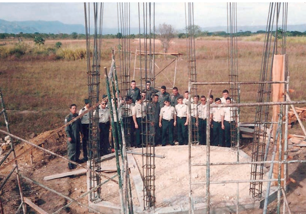
Figura 101. Inicio de la construcción de la torre de control del campo aéreo en Tolemaida (agosto de 1996). Fuente: Carlos Moreno Roa, archivo fotográfico personal
