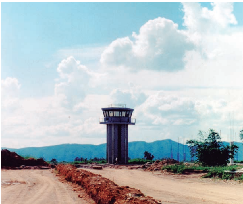
Figura 102. Imagen de la torre control poco después de terminar su construcción. A la derecha se observan las bases en construcción del Hangar de MI-17 (febrero de 1997).
