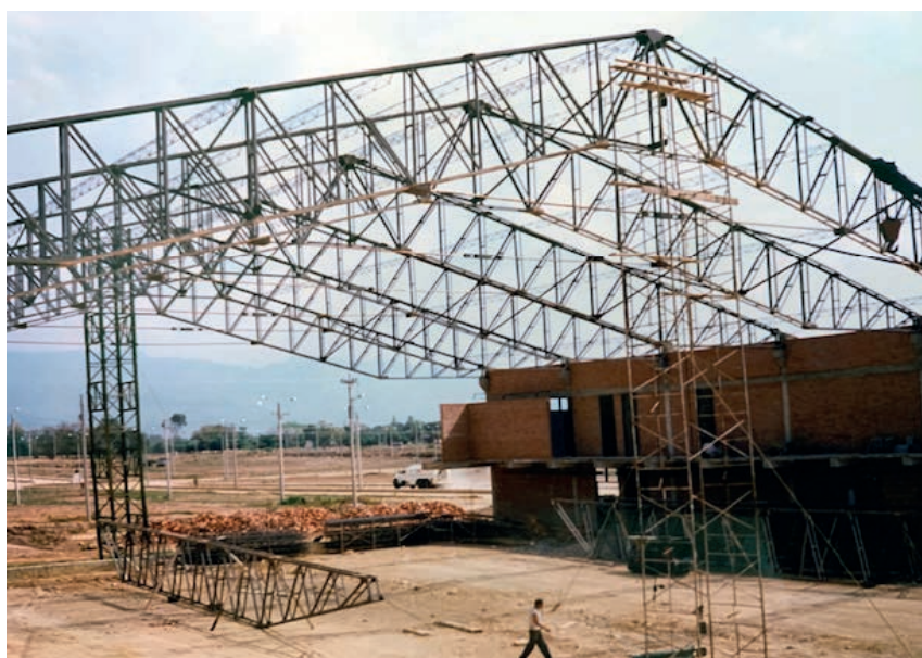
Figura 105. Avance de obra del hangar de MI-17 (diciembre de 1997).
