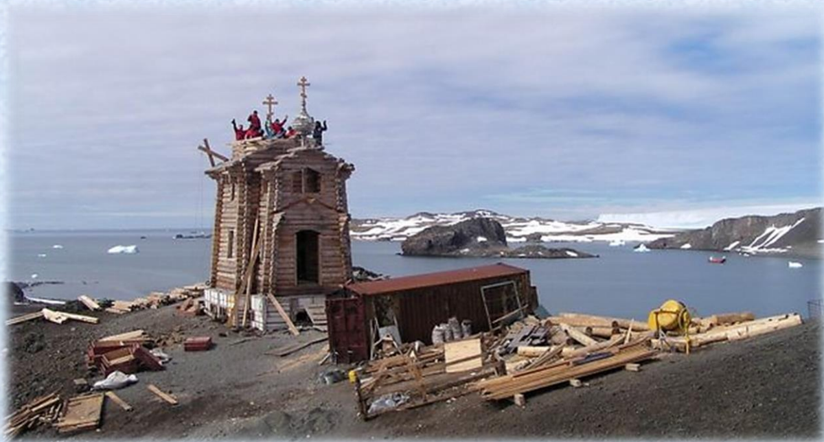
La iglesia durante su avanzada construcción
