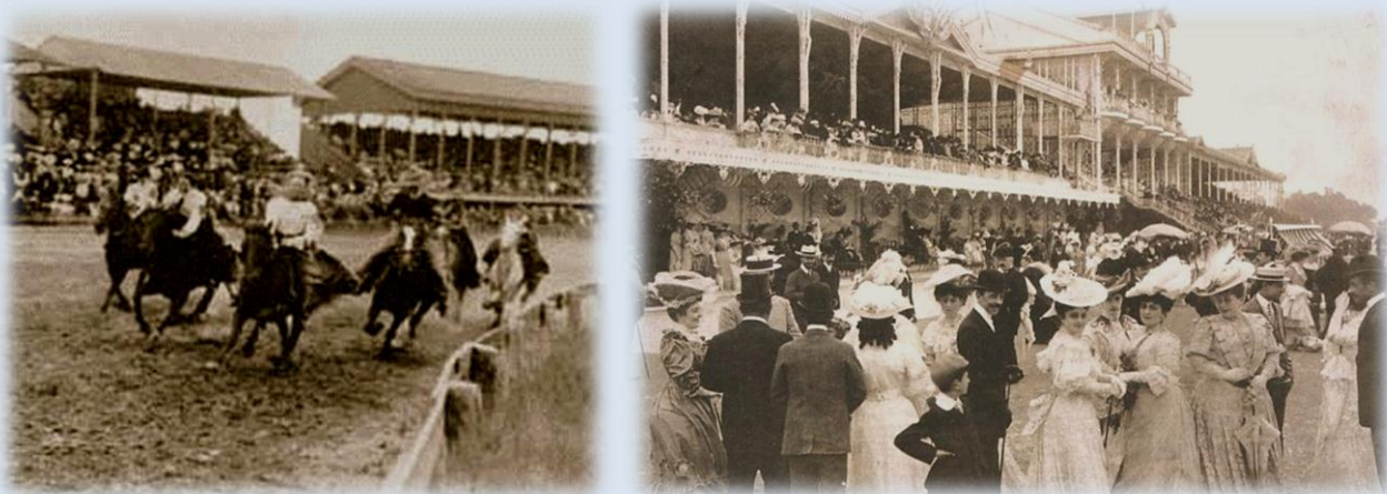
Vistas de las tribunas. A la derecha se aprecia la principal 65
