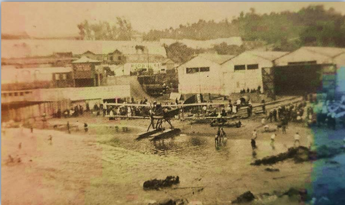
Sacando las aeronaves Short 184 desde el interior de los galpones en Las Torpederas.
