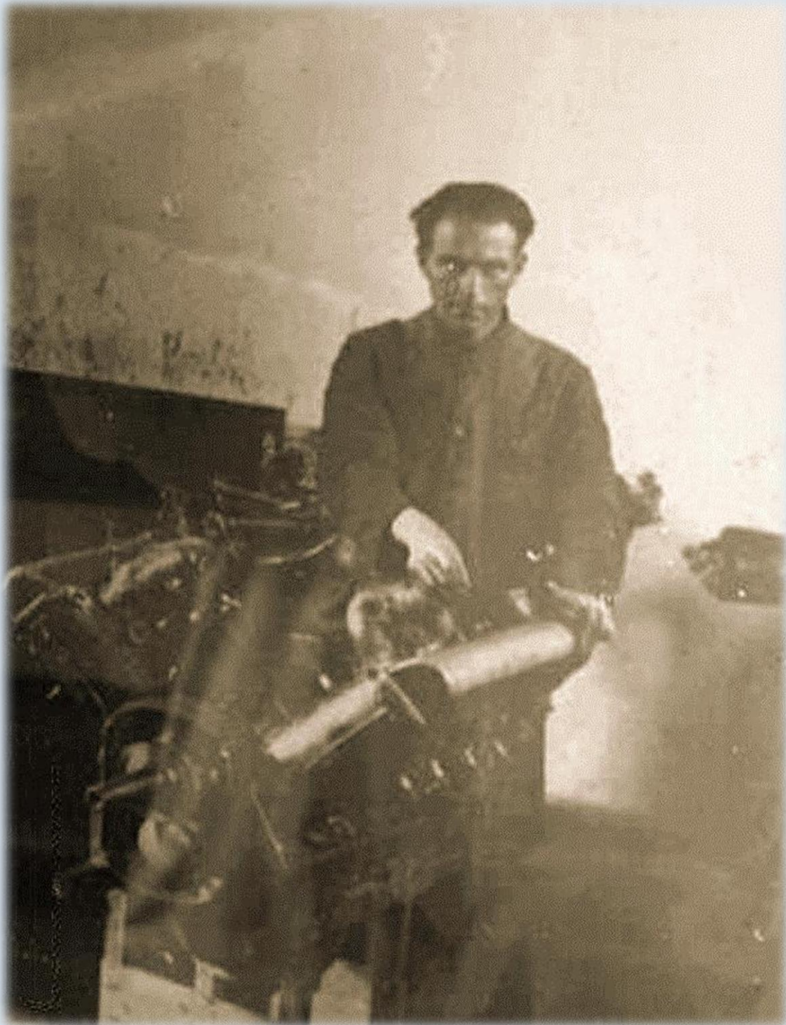
Gómez trabajando sobre un motor Hispano Suiza 8 BEC de 220 hp por ese entonces equipaban los dos Blériot-SPAD uruguayos dados de alta 1920 24
