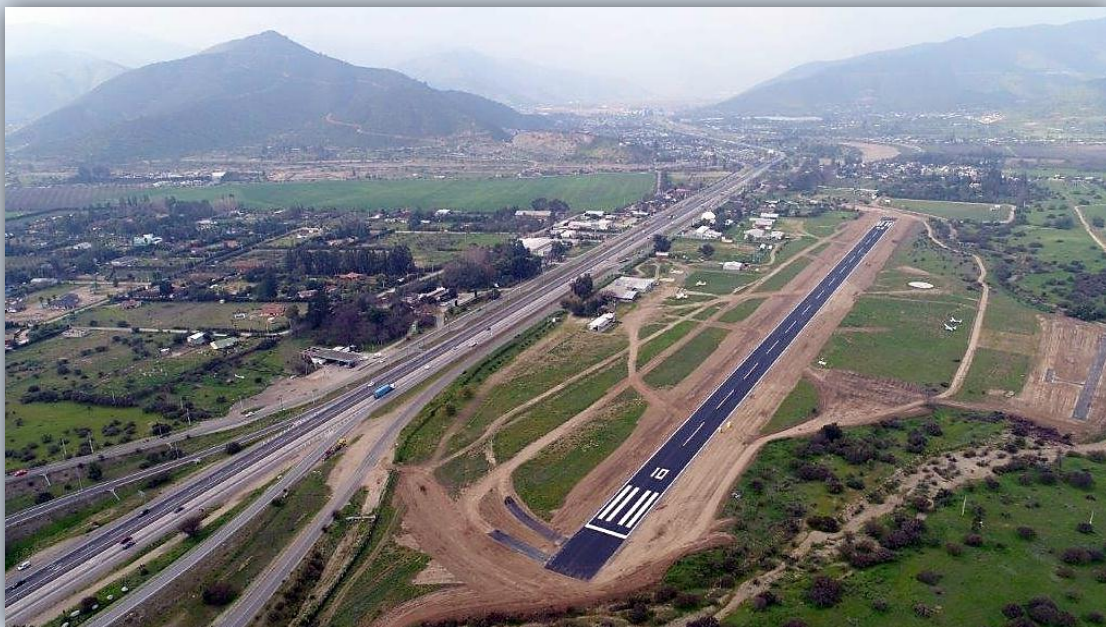
7 de octubre de 2017. Inauguración de la pavimentación de la pista del Aeródromo de Curacavi
