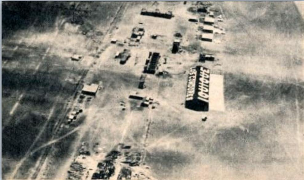
***Base aérea Los Cóndores en Alto Hospicio en la que destaca su hangar metálico de 100 metros de largo por treinta de ancho construido por la Curtiss Airplane Export Corp.***
