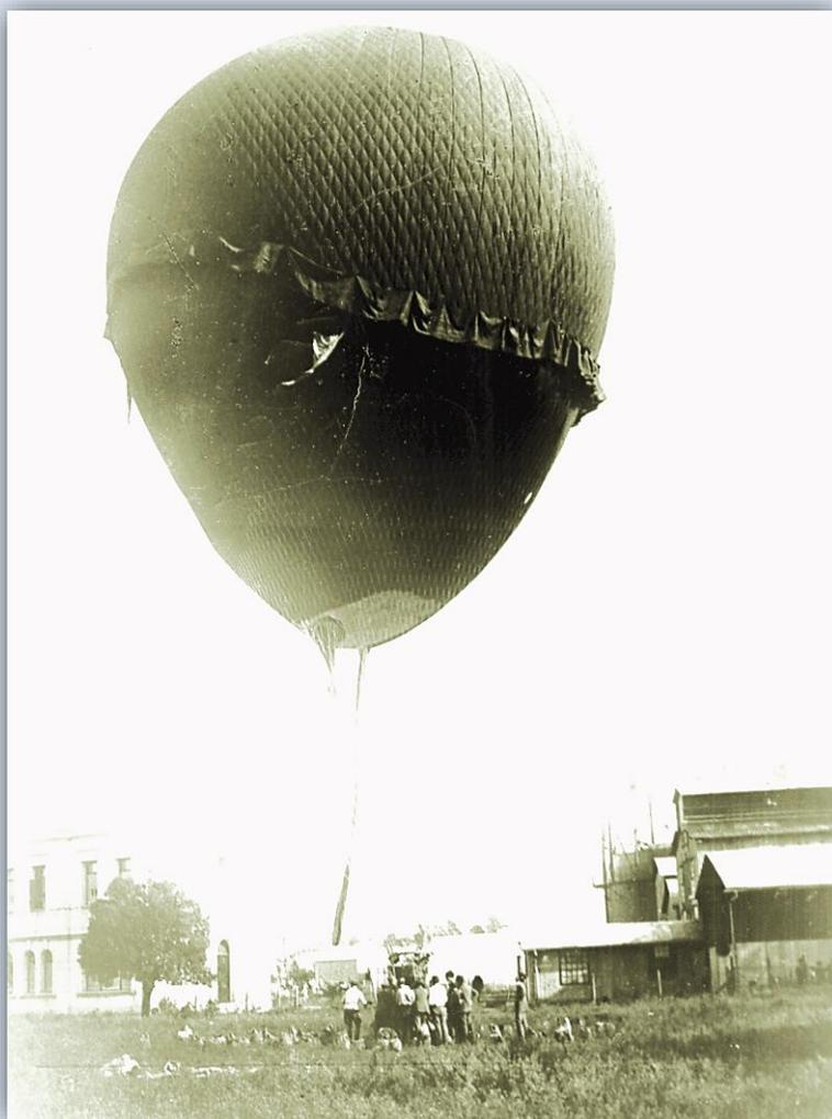
***El Eduardo Newbery antes de despegar desde el Gasómetro de Bernal, en la fotografía se puede apreciar la envoltura con sistema de paracaídas ecuatorial. 13 de abril de 1915***
