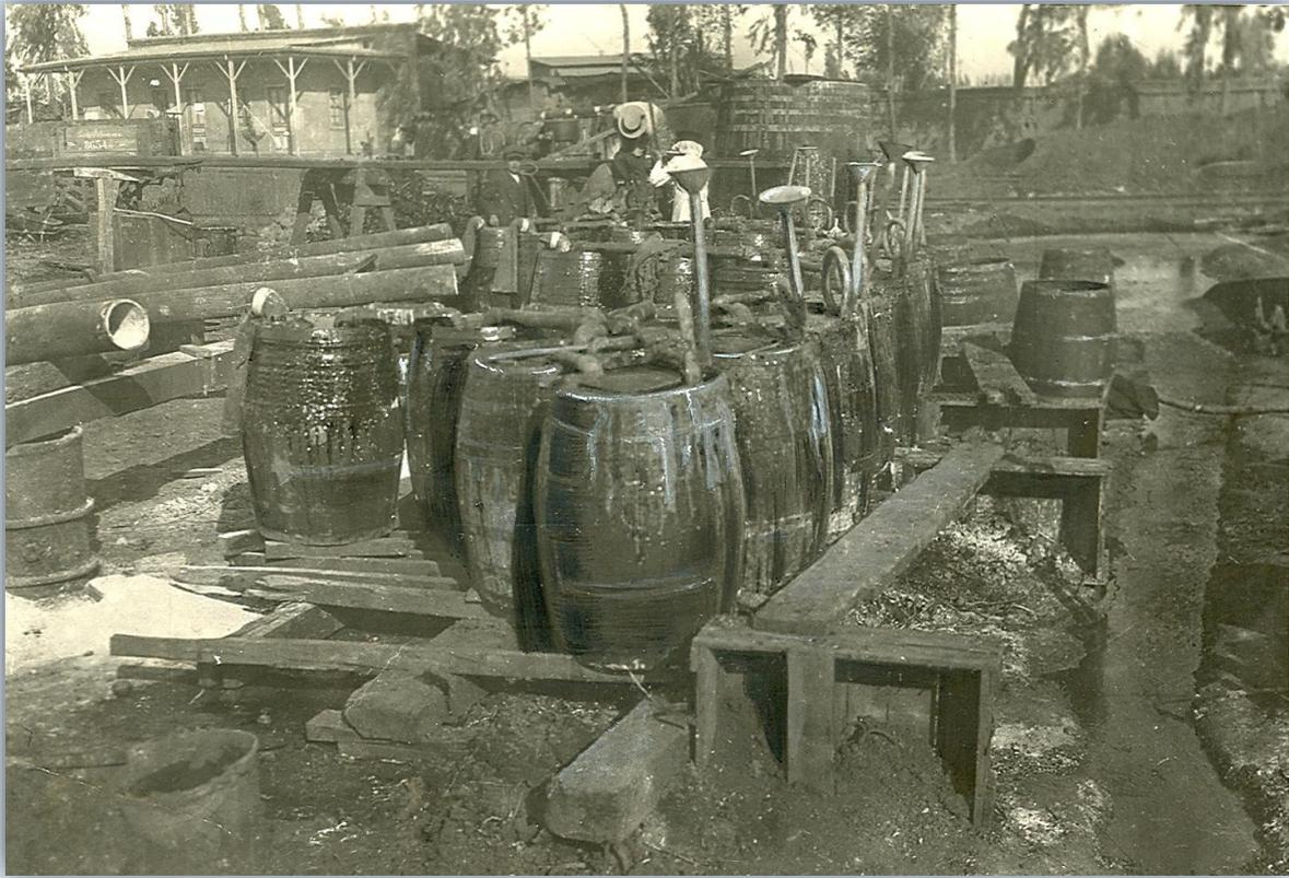
*Planta de gas de San Borja. Barriles de ácido sulfúrico para la producción de hidrógeno. 1916<sup>62</sup>*
