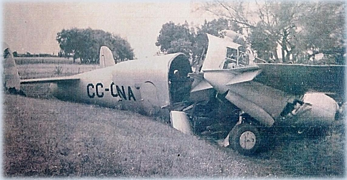
*Estado en que quedó el AT-21 CC-CNA tras sufrir su accidente final. La similitud de daños recibidos por ambos aviones, fractura del fuselaje en la misma cuaderna.*
