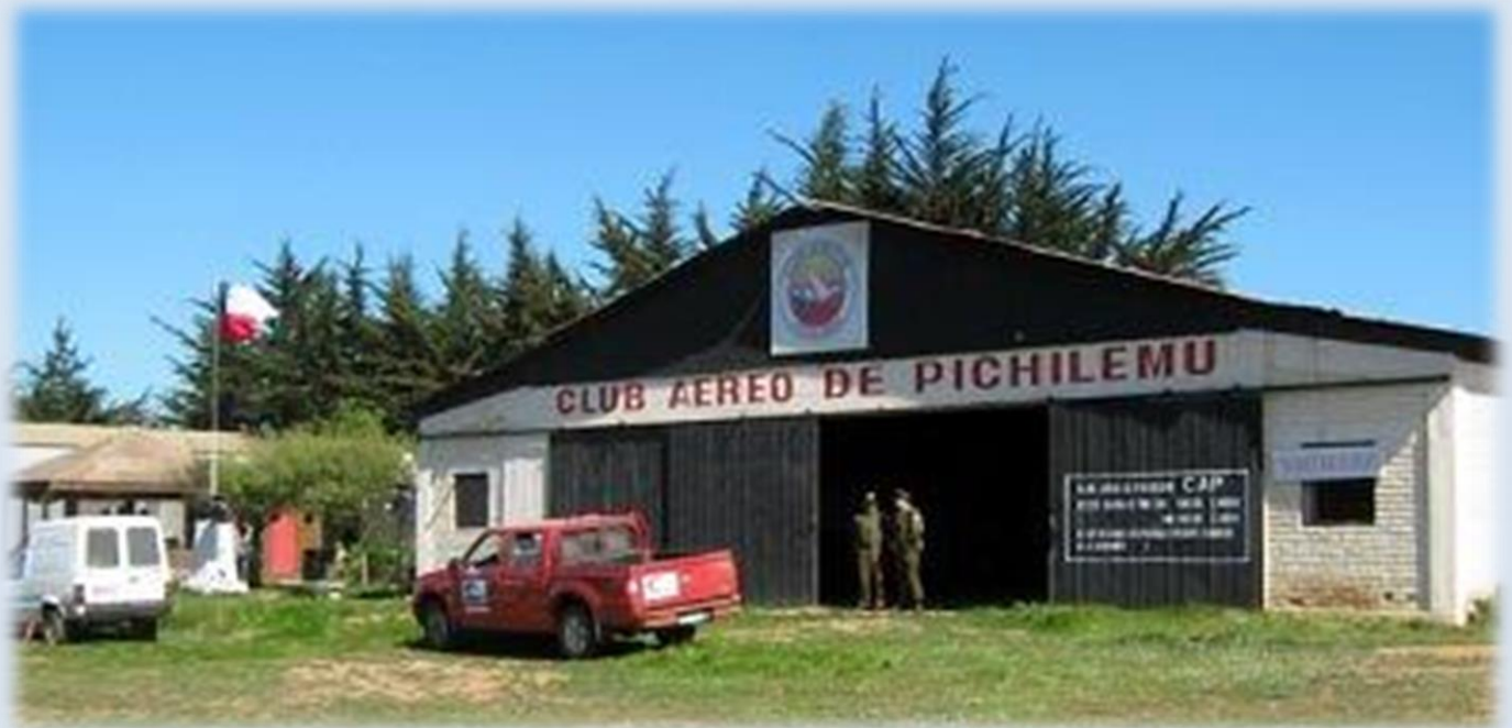
Una vista del Hangar e instalaciones del Club Aéreo de Pichilemu (Foto: J. Nasser G.)
